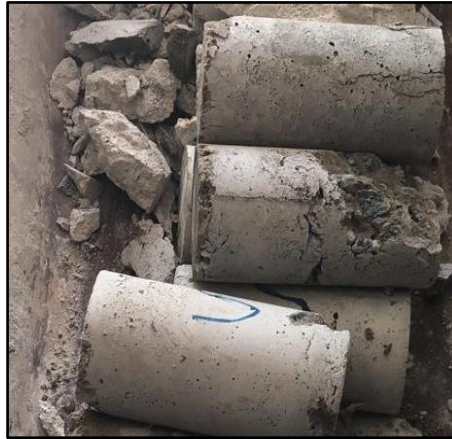
Figura 11 – Corpos de prova pós-rompimento
