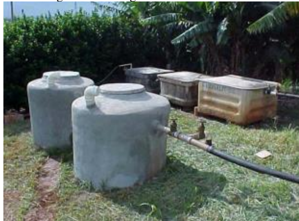
Figura 5: Visão geral do RAC finalizado
