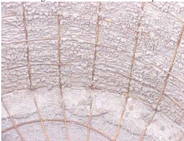
Figura 2: Vista do RAC em construção
