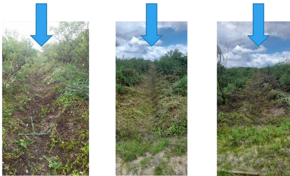
Imagem 3. Visualização de desbastes das plantas invasoras na área experimental Limpeza e desbastes entre blocos (corredores)
