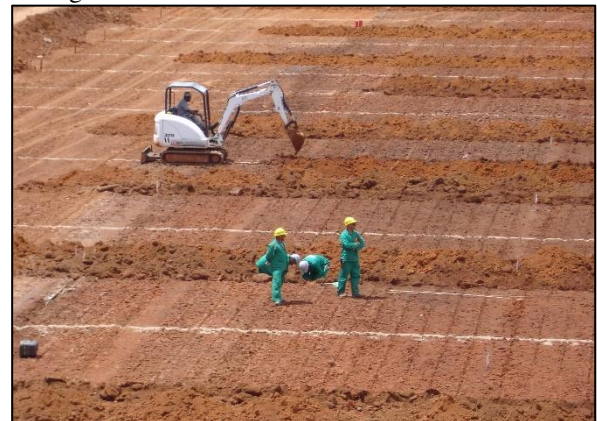
Figura 13. Abertura das trincheiras transversais.
