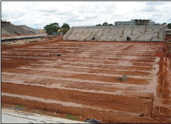
Figura 16. Preenchimento das trincheiras com areia lavada.
