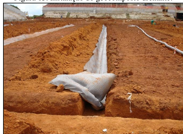
Figura 15. Instalação do geocomposto drenante.
