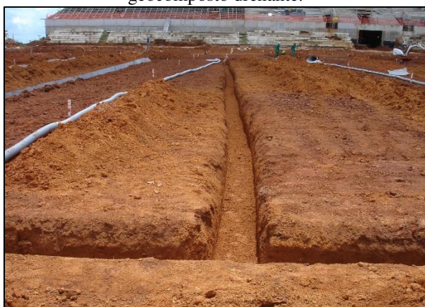
Figura 14. Trincheiras limpas para instalação do geocomposto drenante.
