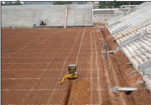
Figura 12. Abertura das trincheiras longitudinais.
