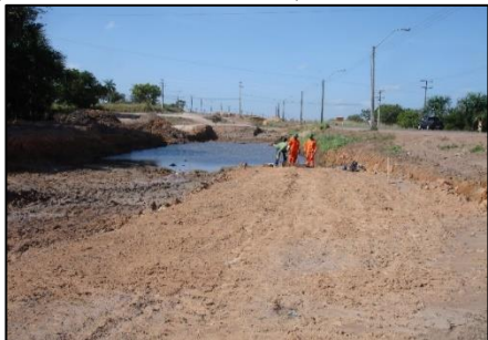
Figura 4. Vista do trecho 1 (Estacas 181 a 188).
