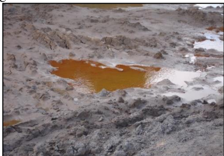
Figura 6. Existência de solo mole no trecho 1.
