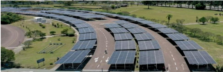
Usina minigeração da Universidade Federal do Paraná.
