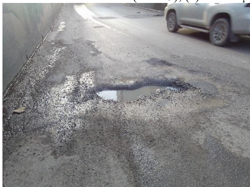
Mau remendo e/ou panelas
