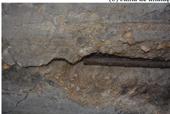
Exposição e corrosão das armaduras
