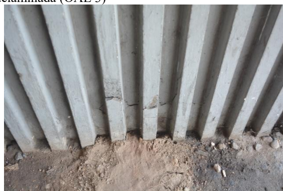
(e) Fissuração e descasque do betão num pilar (OAE 1)
