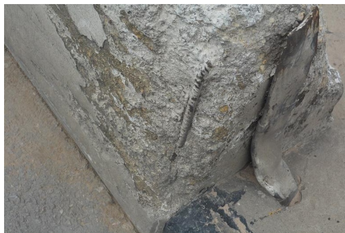
(d) Barreira New Jersey delaminada (OAE 3)
