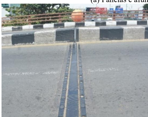
Ausência de alvéolos de fixação e fenda no remate entre a junta e acamada de transição
