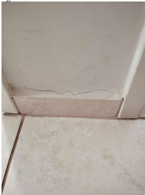
Figura 5. Saliência em revestimento cerâmico.
