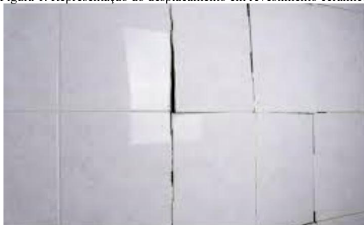
Figura 1. Representação do deslocamento em revestimento cerâmico.
