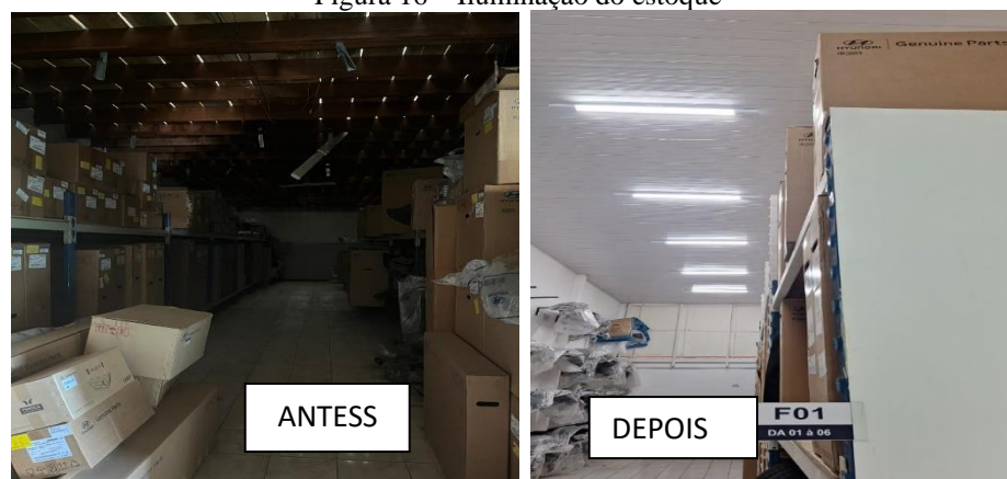
Figura 16 – Iluminação do estoque
