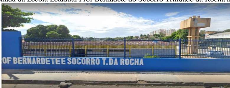
Figura 1– Fachada da Escola Estadual Prof Bernadete do Socorro Trindade da Rocha no ano de 2021.
