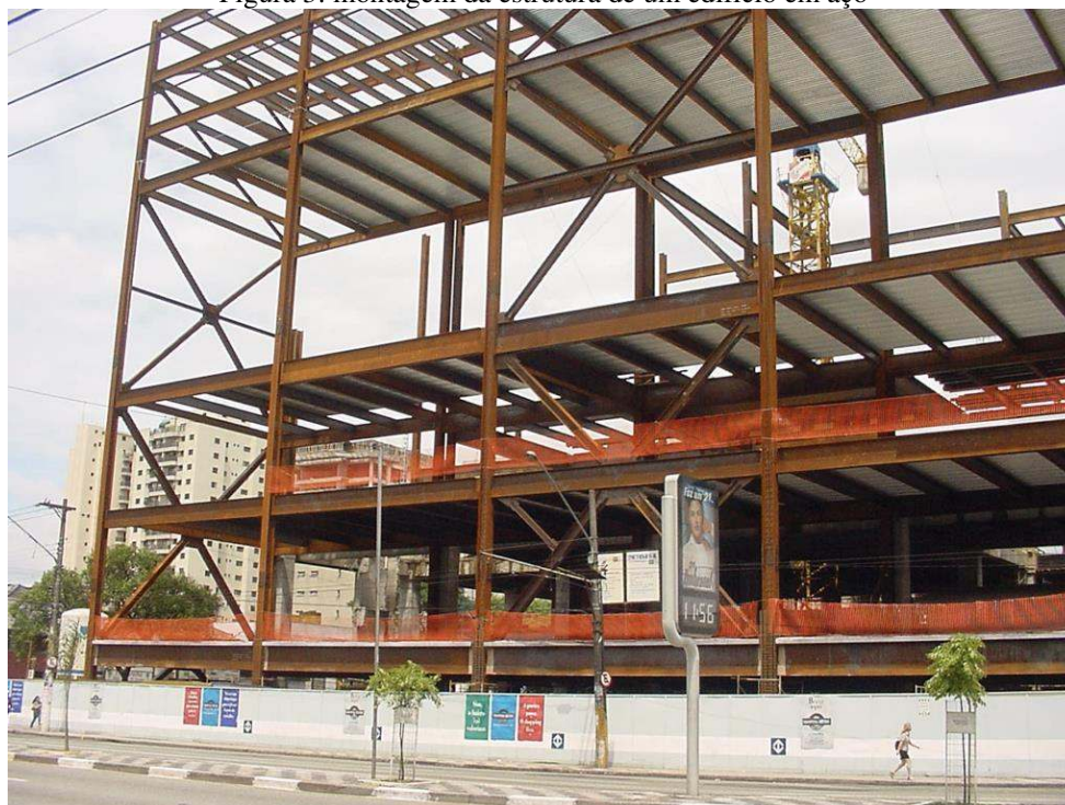
Figura 3: montagem da estrutura de um edifício em aço
