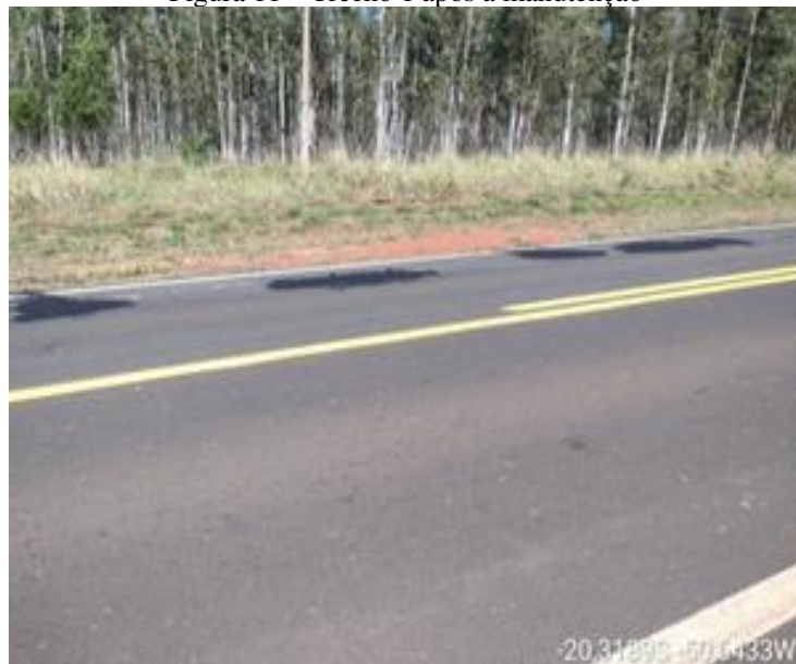
Figura 11 – Trecho 1 após a manutenção
