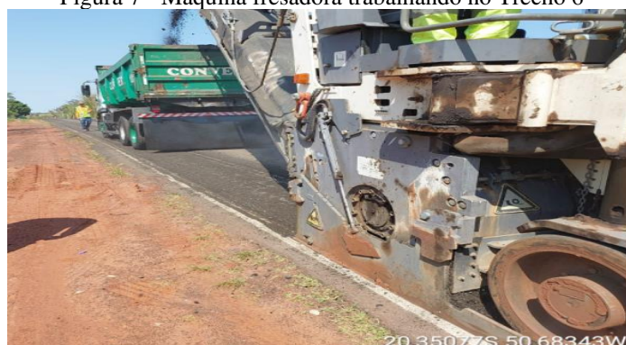
Figura 7 - Máquina fresadora trabalhando no Trecho 6
