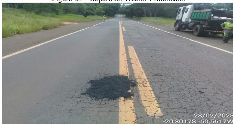
Figura 20 - Reparo do Trecho 4 finalizado
