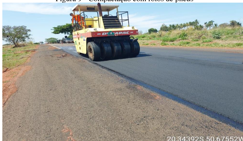
Figura 9 - Compactação com rolos de pneus
