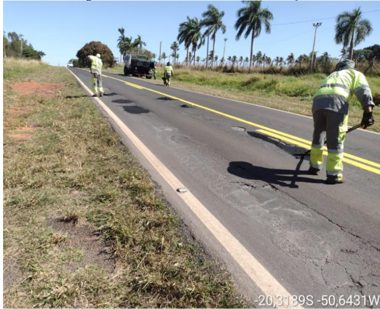
Figura 10 – Trecho 1 durante a manutenção
