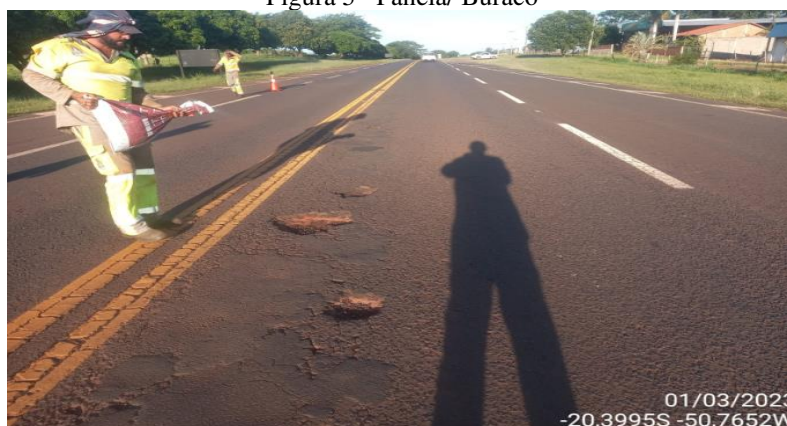
Figura 5– Panela/ Buraco
