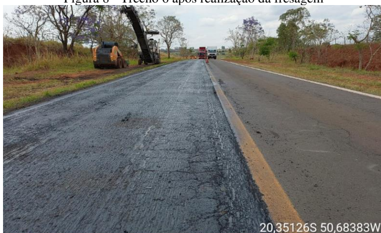
Figura 8 - Trecho 6 após realização da fresagem
