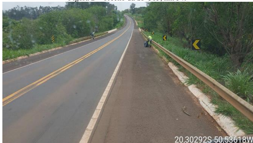
Figura 2 – Trecho da SP-563, km 349
