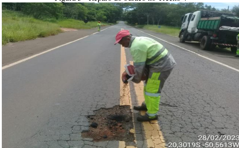
Figura 5 - Reparo do buraco no Trecho 4
