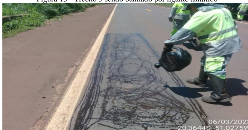
Figura 15 - Trecho 3 sendo banhado por ligante asfáltico
