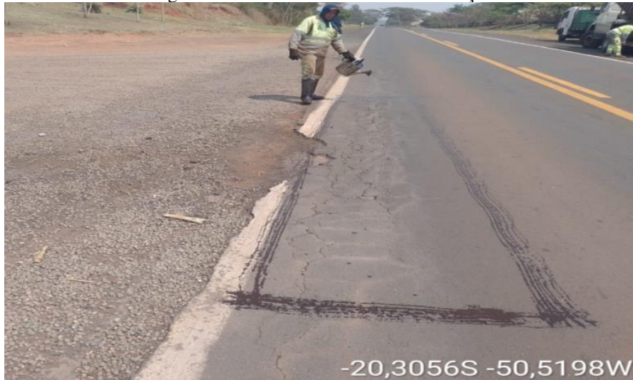
Figura 123 – Trecho 2 durante a manutenção
