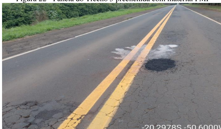
Figura 22 - Panela do Trecho 5 preenchida com material PMF
