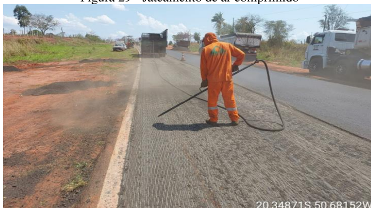
Figura 29 - Jateamento de ar comprimido
