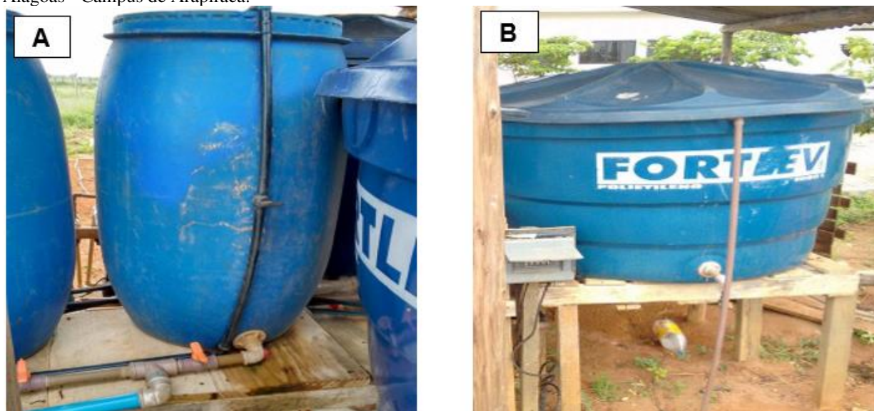
Figura 10 - Tonel utilizado para a fertirrigação (A) e reservatório de água (B), na área experimental da Universidade Federal de Alagoas - Campus de Arapiraca.
