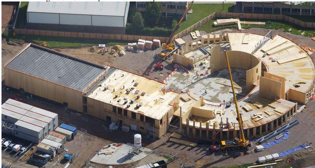
Figura 3– Construção em CLT da Open Academy Norwich , no Reino Unido
