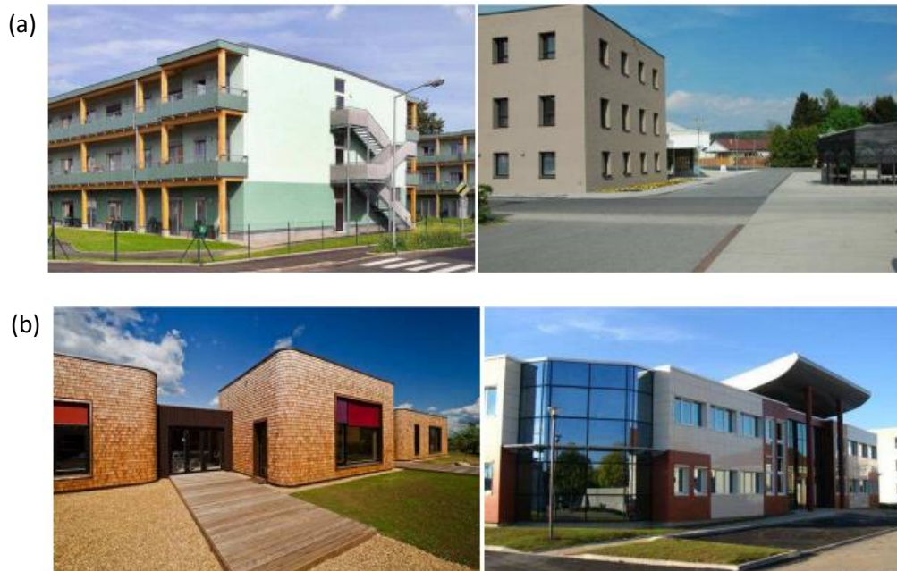
Figura 7– (a) Edifícios com revestimento de argamassa (b) Edifícios com revestimento cerâmico
