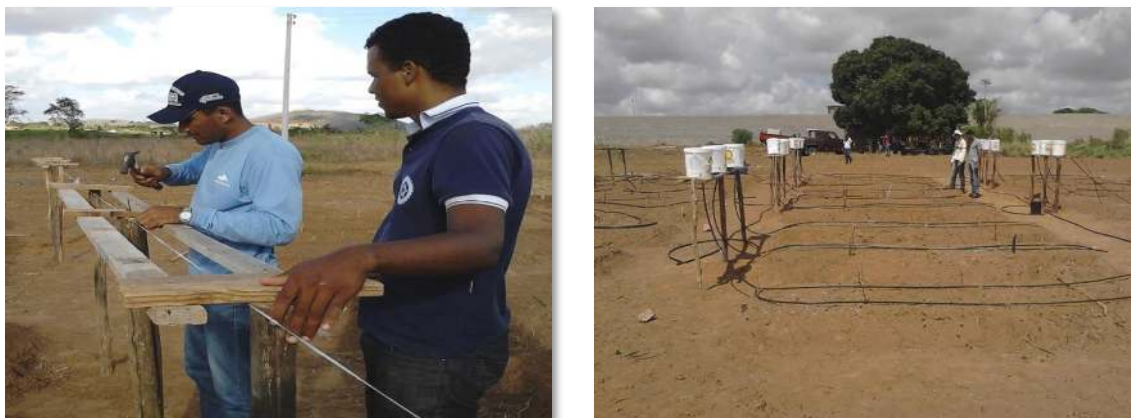
Figuras 4. Montagem da bancada para suspensão dos reservatórios que alimentam o sistema de irrigação por gotejamento
