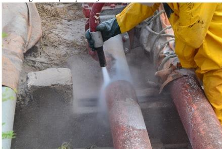
Figura 3: Aplicação de jateamento úmido com abrasivos.
