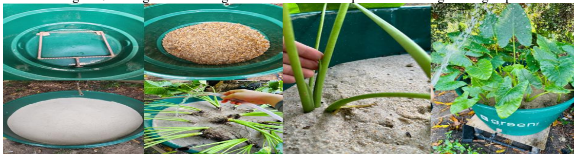
Figura 02: Imagens da montagem no local escolhido para receber a água do igarapé.
