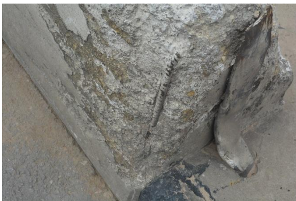
(d) Delaminated New Jersey Barrier (OAE 3)
